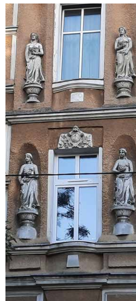
Cztery postacie kobiece w strojach antycznych w niszach na fasadzie kamienicy przy ul. Wielkopolskiej 22
