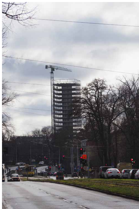
Rewitalizacja dawnego wieżowca PRiTV, luty 2022
