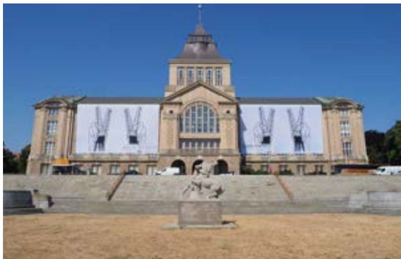
Upalne lato spowodowało suszę, sierpień 2020
