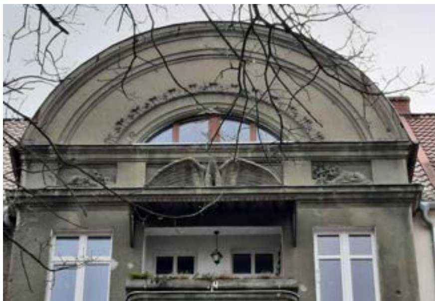
Orzeł na fasadzie kamienicy przy ulicy Zygmunta Starego 5
