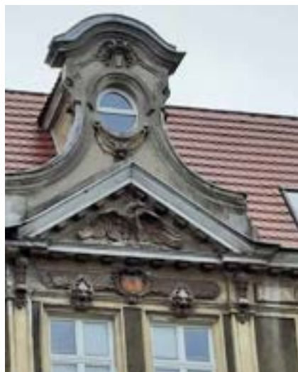
Orzeł pruski na kamienicy przy placu Grunwaldzkim przed remontem
