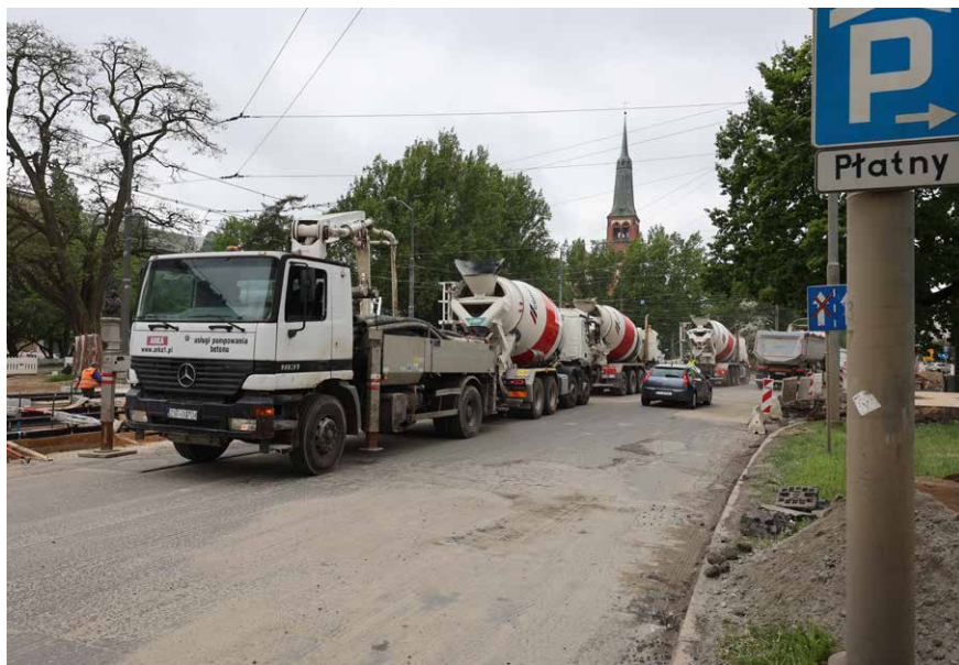
Remont Bramy Portowej, maj 2023
