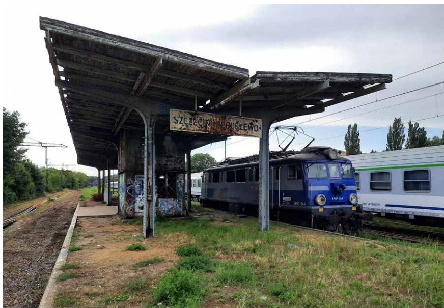
Stacja Szczecin-Niebuszewo, lipiec 2023
