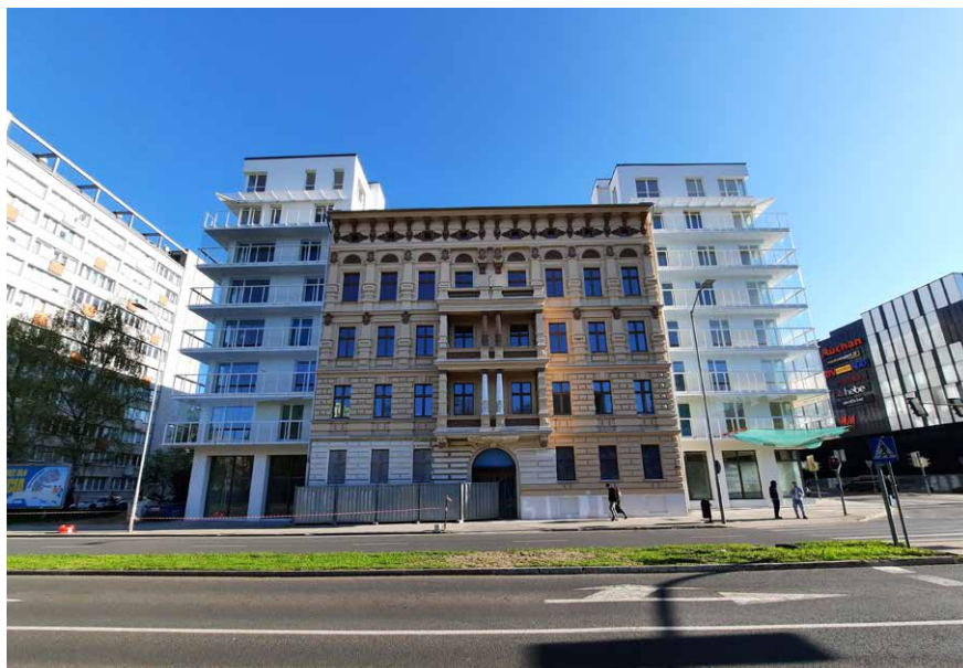
Renowacja jedynej ocalałej z czasów wojny kamienicy przy ul. Matejki, kwiecień 2023
